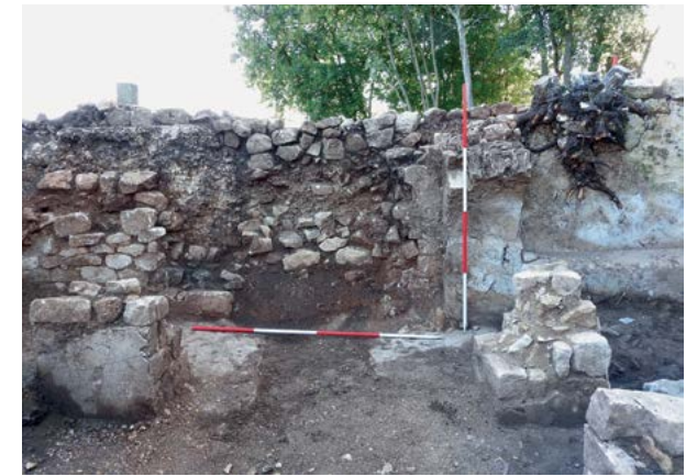
Slika 147. Razrušeni istočni zid cisterne.
