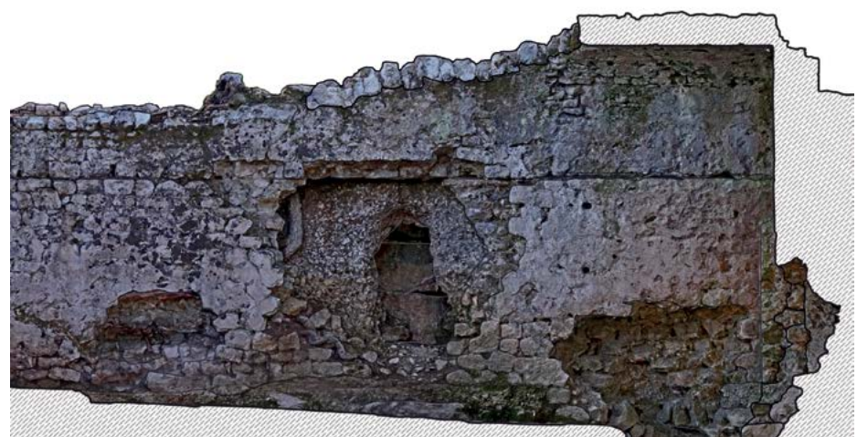
Slika 139. Degradirani južni zid cisterne nakon iskopavanja.
